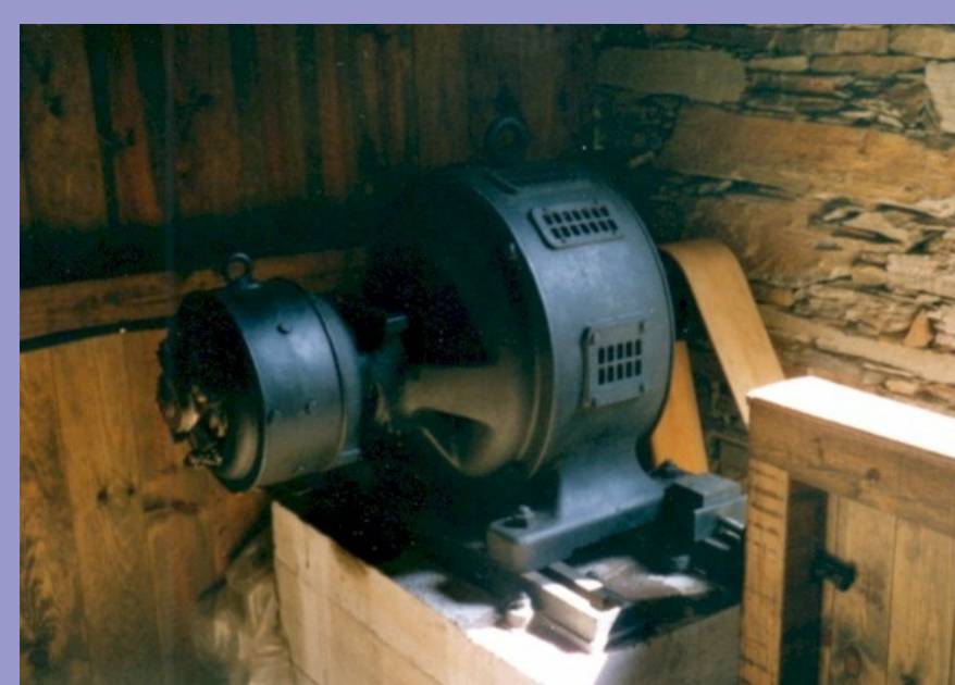
Alternador en la Ferreiría de Bogo (A Pontenova, Lugo), otro ejemplo de reconversión hidroeléctrica
